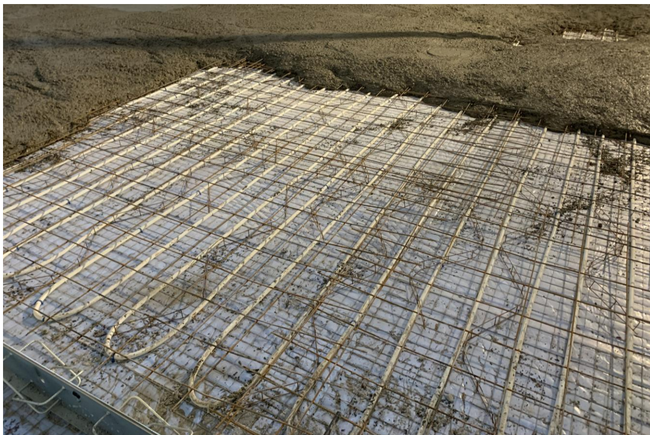
Figura 7. Particolare del sistema di riscaldamento radiante predisposto – AREA 2-PACK LINE
