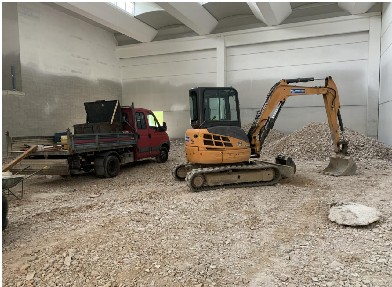
Figura 2. Preparazione del sottofondo della pavimentazione
