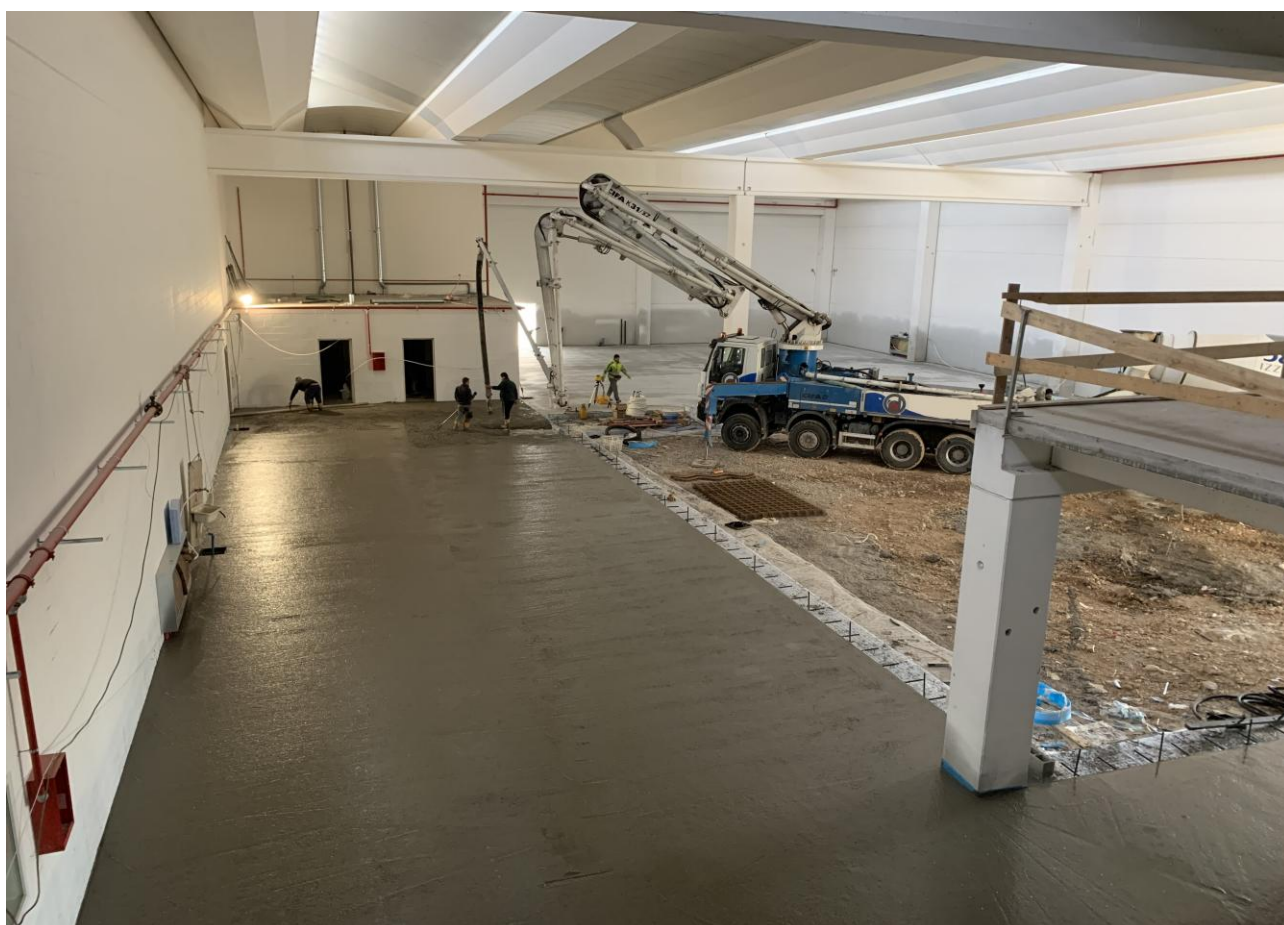
Figura 9. Fasi di getto della pavimentazione fibrorinforzata con FIBRAG® POLY: PSF 55-TP – AREA 2-PACK LINE
