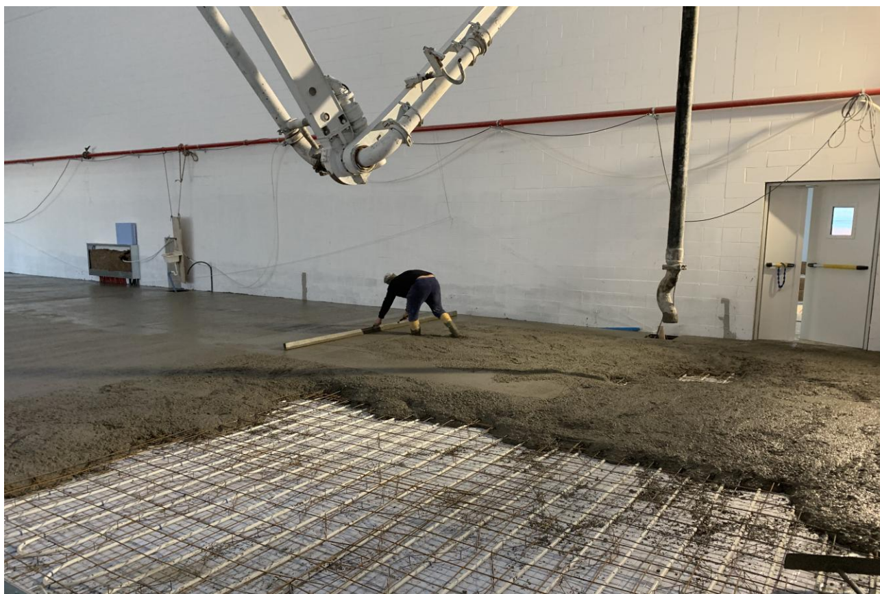
Figura 8. Fasi di stesura della pavimentazione fibrorinforzata con FIBRAG® POLY: PSF 55-TP – AREA 2-PACK LINE
