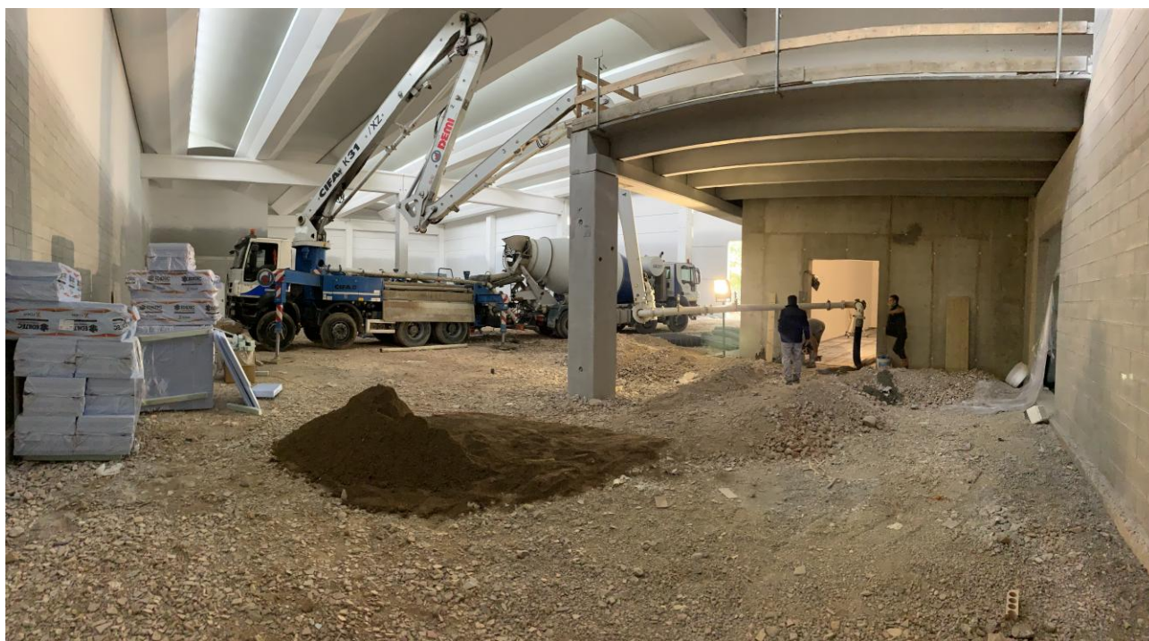
Figura 3. Getto del calcestruzzo fibrorinforzato con ausilio di autopompa – AREA 3-CAVEAU
