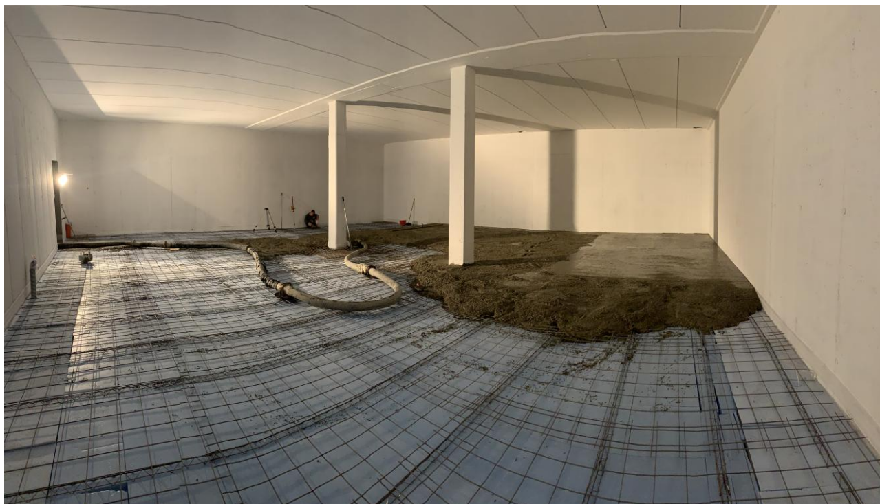
Figura 5. Fasi di getto della pavimentazione fibrorinforzata con FIBRAG® POLY: PSF 55-TP – AREA 3-CAVEAU
