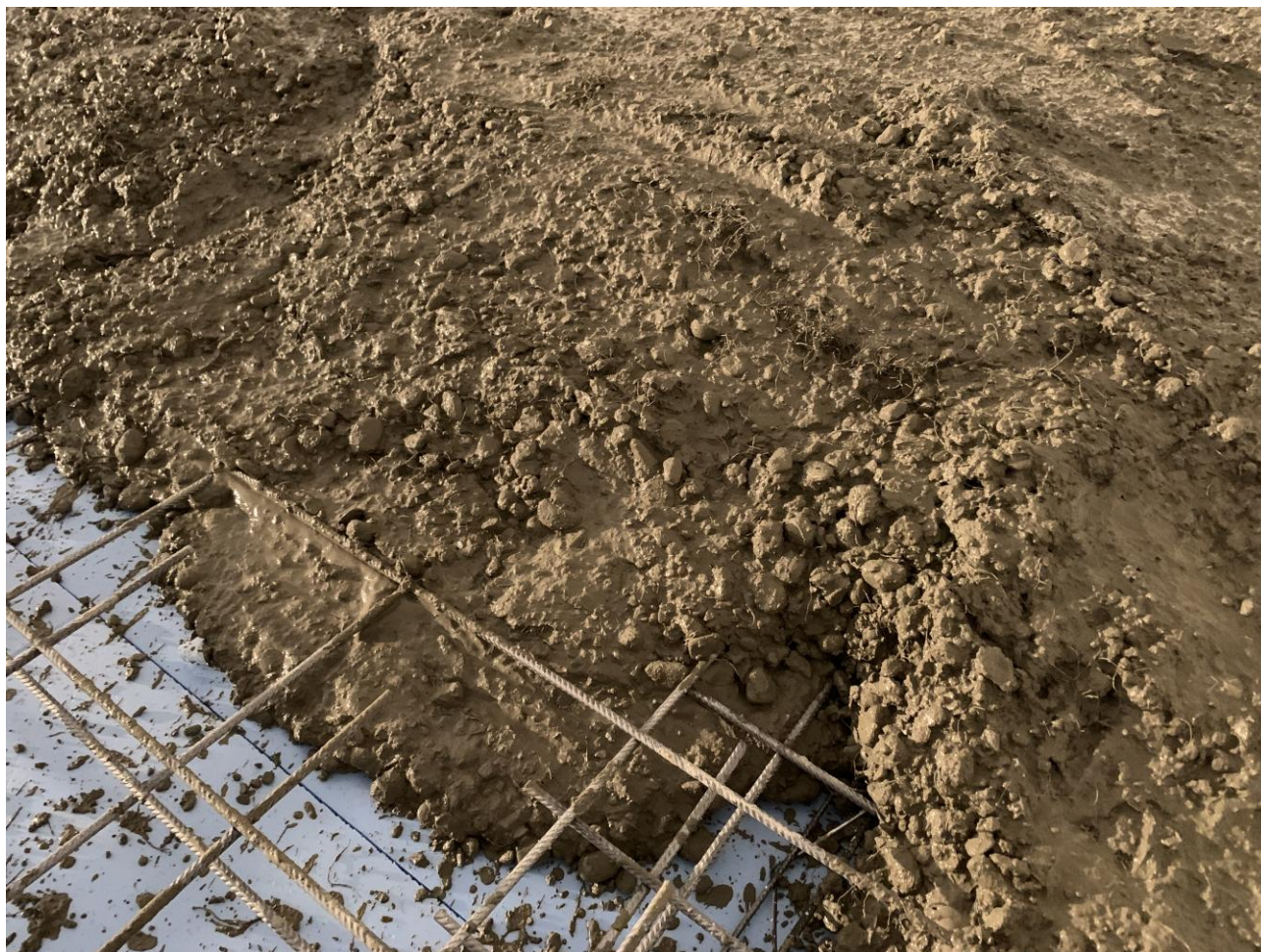
Figura 6. Particolare getti calcestruzzo fibrorinforzato con fibre polimeriche FIBRAG® POLY: PSF 55-TP
