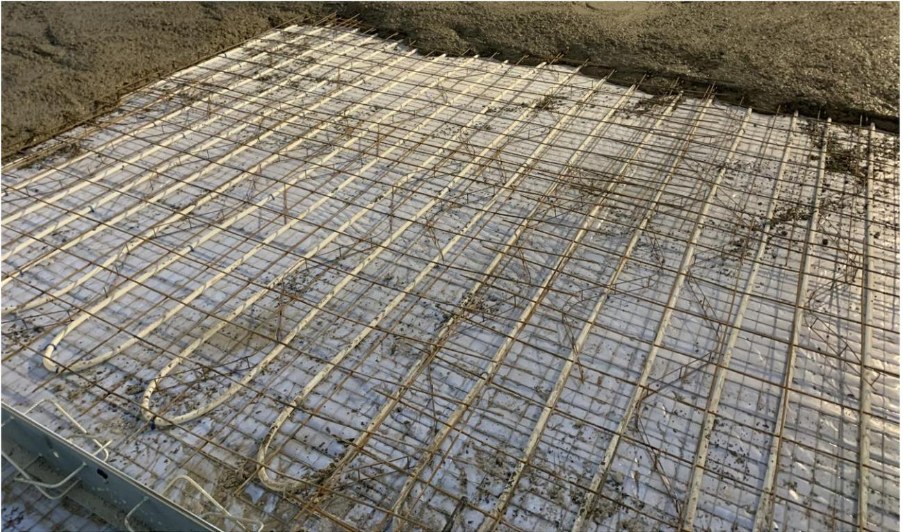
**Figura 7.** Particolare del sistema di riscaldamento radiante predisposto – AREA 2-PACK LINE
