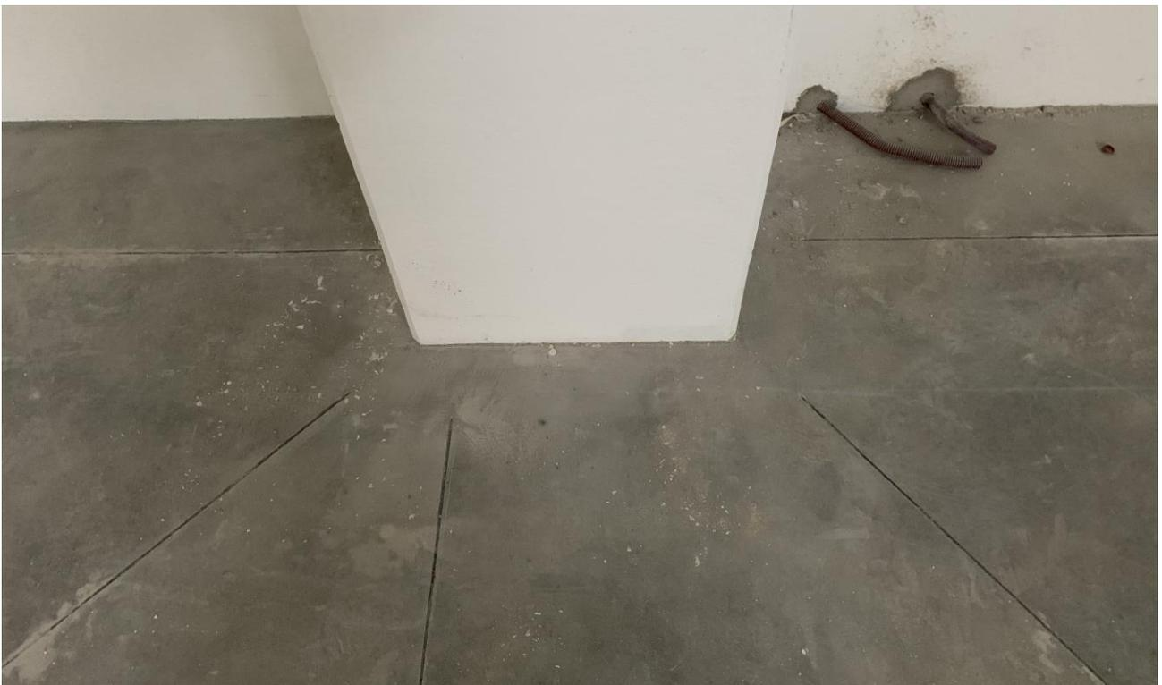
Figura 10. Particolare della cura adottata in fase di realizzazione di giunti di controllo in prossimità di elementi di discontinuità
