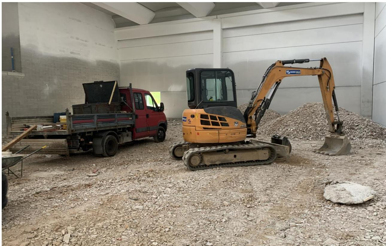
Figura 2. Preparazione del sottofondo della pavimentazione
