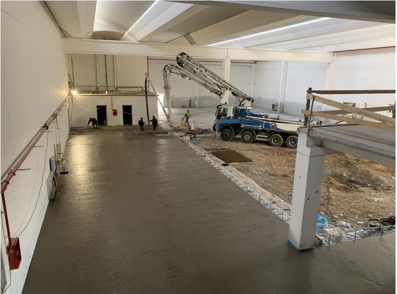
Figura 9. Fasi di getto della pavimentazione fibrinforzata con FIBRAG® POLY: PSF 55-TP – AREA 2-PACK LINE
