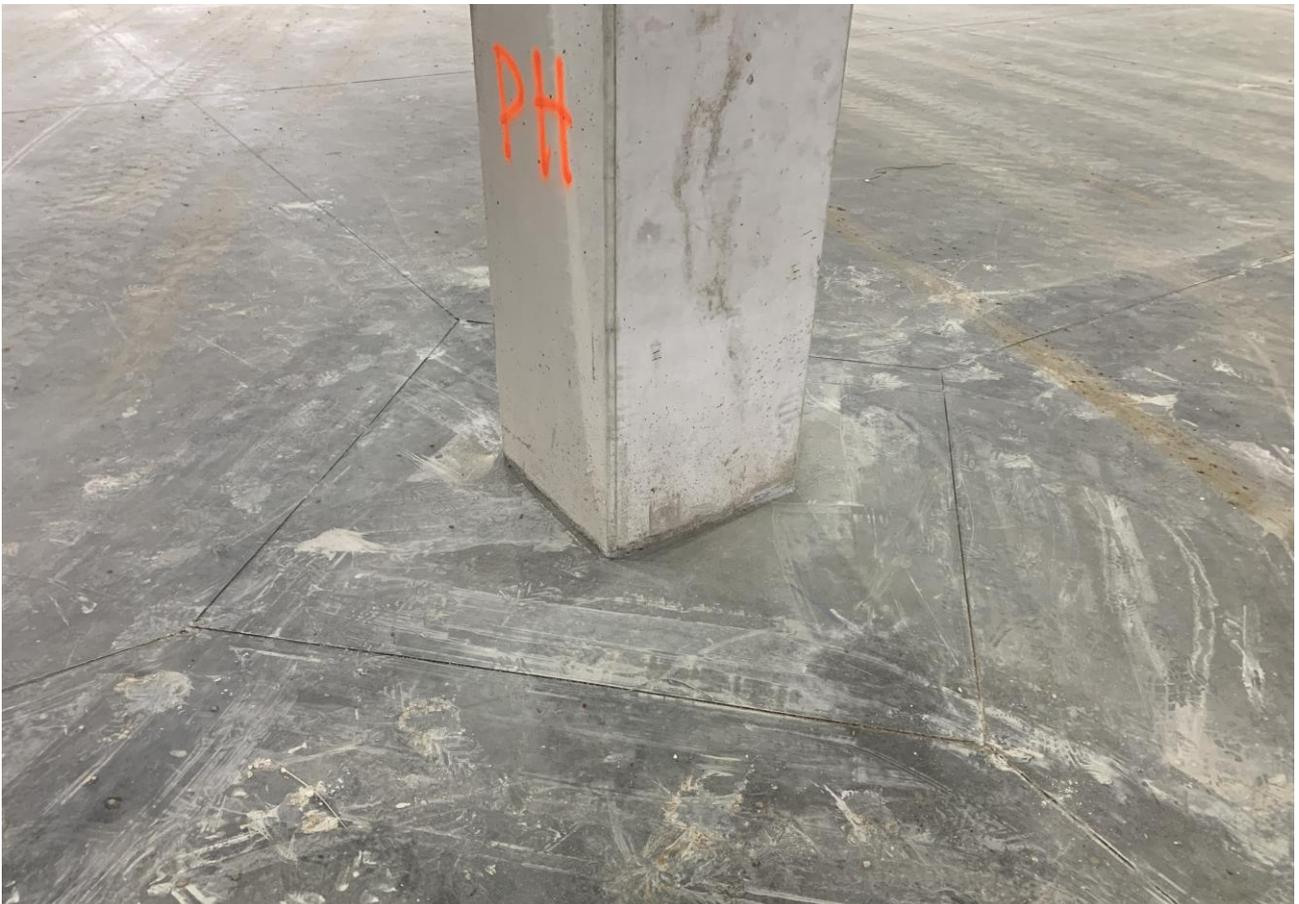
**Figura 6.** Particolare della cura adottata in fase di realizzazione di giunti di controllo in prossimità di elementi di discontinuità
