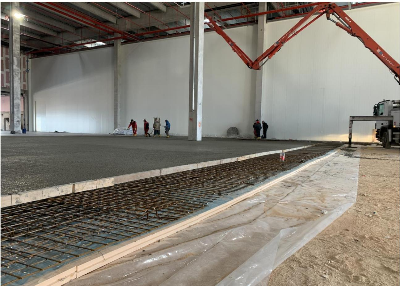
**Figura 2.** Fasi di getto della pavimentazione fibrorinforzata con FIBRAG® STEEL: F-WG 60/80 SHT e ausilio di autopompa
