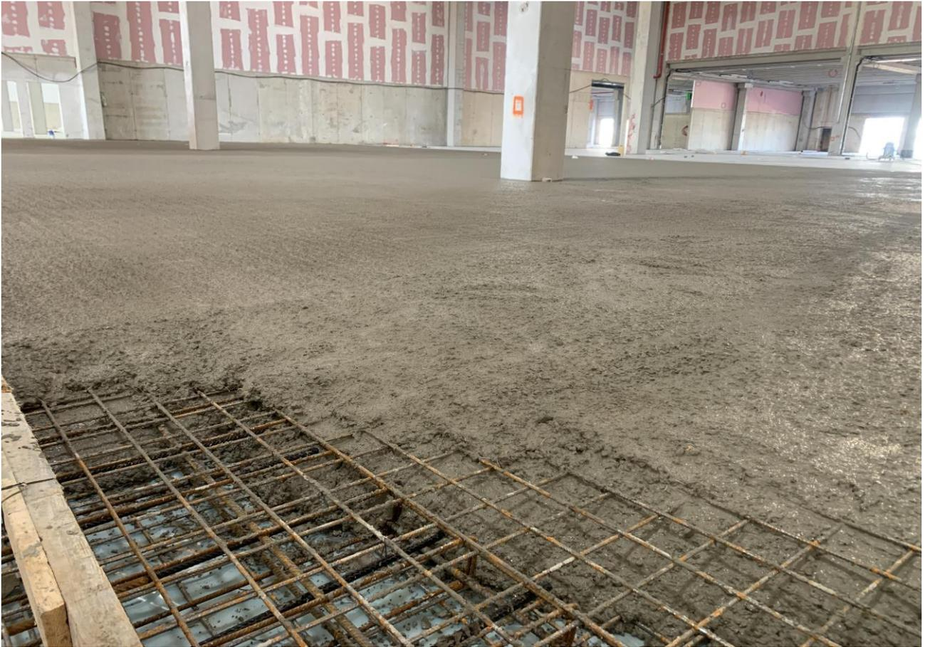
**Figura 3.** Fasi di getto della pavimentazione fibrorinforzata con FIBRAG® STEEL: F-WG 60/80 SHT
