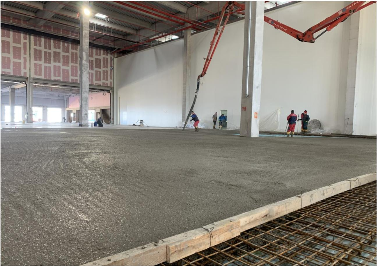
**Figura 5.** Fasi di getto della pavimentazione fibrorinforzata con FIBRAG® STEEL: F-WG 60/80 SHT e ausilio di autopompa
