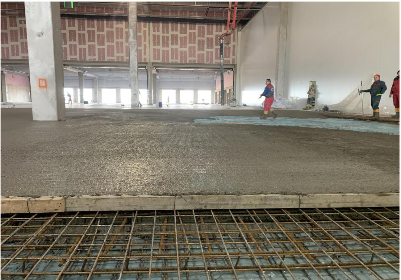
**Figura 4.** Fasi di getto della pavimentazione fibrorinforzata con FIBRAG® STEEL: F-WG 60/80 SHT
