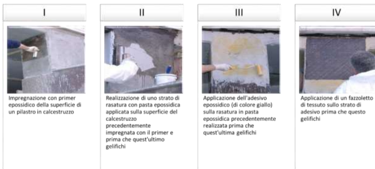
Fig. 9 – Sequenza di operazioni per l'incollaggio di tessuti con sistemi epossidici
