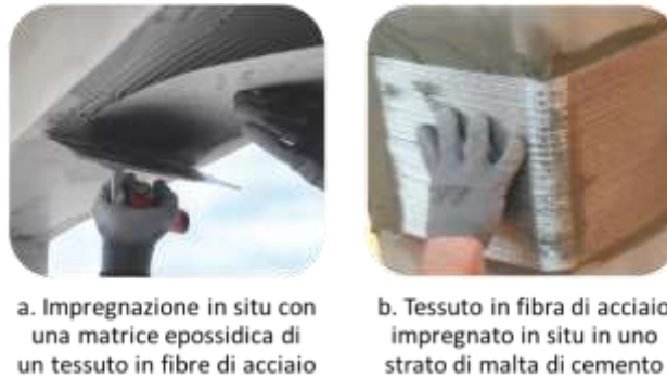
Fig. 2 – Modalità di impregnazione in situ dei sistemi
