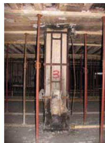
Figura 2 – Pilastro ed impalcato in c.a. danneggiato da incendio [foto dell'Autore]
