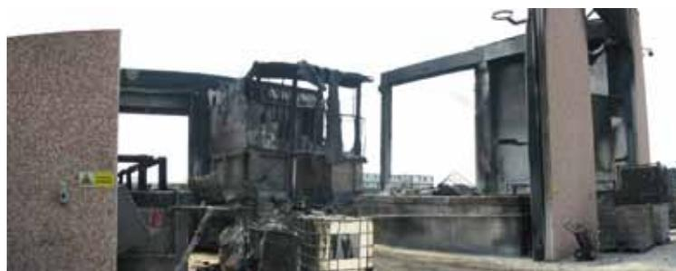
Figura 1 – Impianto industriale in c.a. e cap prefabbricato completamente distrutto da un incendio [foto dell'Autore]
