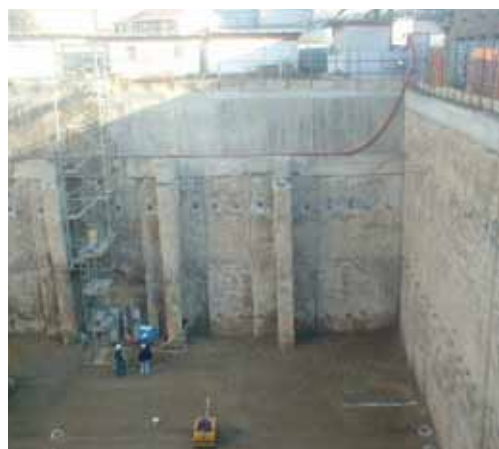
Viste delle paratie con sezione a "T"
