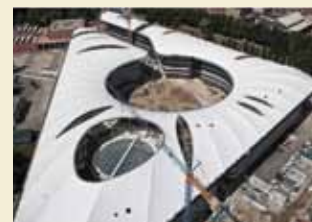
Vista dall'alto, si osservi la continuità strutturale della membrana (concessione Michele D'Ottavio photographer)
