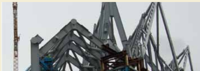
Collegati gli elementi strutturali della copertura nella zona di transizione, un sistema di puntelli in movimento ha consentito la progressione simultanea della copertura verso le due facciate vetrate. (© Zaha Hadid Architects)
