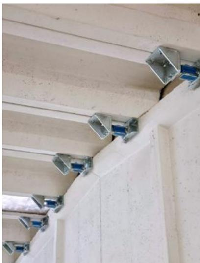
L'efficacia dell'intervento si incrementa ulteriormente se realizzato con l'impiego di dispositivi di dissipazione di energia come quelli proposti da **SismoCell**, che oltre a collegare gli elementi strutturali consentono anche di dissipare parte dell'energia prodotta dal sisma riducendo le sollecitazioni sui pilastri.
