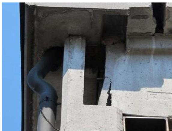
Fig.1 Vulnerabilità locale nodo trave-pilastro
