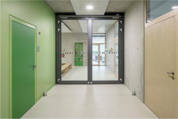
**Figura 13:** Gli elementi per telaio tubolare in acciaio Hörmann creano compartimenti antincendio nei grandi corridoi, fornendo allo stesso tempo luce diurna e trasparenza. Le porte Schörghuber - Gruppo Hörmann conducono all'area sanitaria (a sinistra, resistente all'umidità) e separano il corridoio dall'aula scolastica (a destra, T30 tagliafuoco e tagliafumo).
