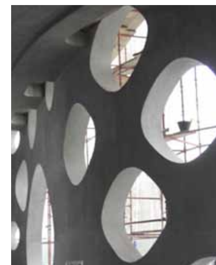
Figura 2. O-14, edificio per uffici, Dubai, United Arab Emirates, Reiser + Umemoto Architects – Vista della realizzazione dello scheletro in calcestruzzo gettato in opera.
