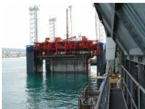
Figura 3. Uso di slipform per costruire cassoni a mare. Il cassero viene sollevato progressivamente mediante 4 gru. Non si impiegano le barre di sollevamento [4] forme (7).
