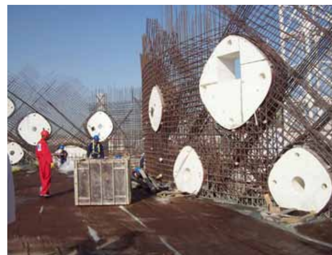
Figura 2. O-14, edificio per uffici, Dubai, United Arab Emirates, Reiser + Umemoto Architects – Vista della realizzazione dello scheletro in calcestruzzo gettato in opera.
