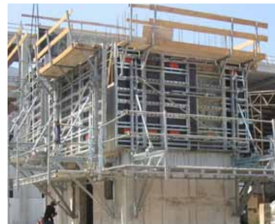
Figura 1. Sistema di costruzione a cassero rampante. I casseri sono fissati alle pareti e, dopo il getto, smontati e sollevati in una posizione più alta, quando il calcestruzzo presenta una resistenza sufficiente (foto da Internet)
