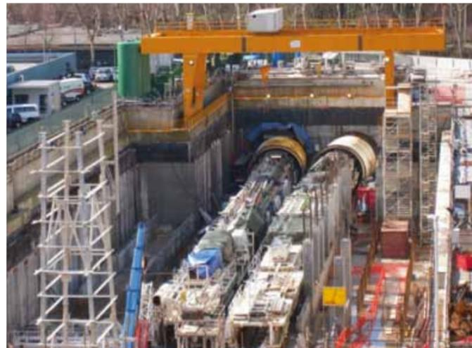
Figura 1 – Nuova linea M4, stazione di Milano Linate - Le TBM pronte per l'esecuzione dello scavo
