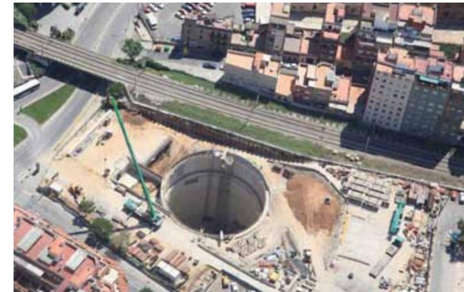
Figura 2 – Pozzo di arrivo TBM e stazione Torrassa metro di Barcellona
