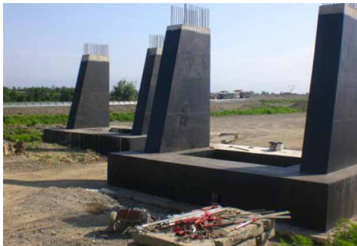
Figura 2. Colonne delle spalle per il Viadotto Pk 15.
