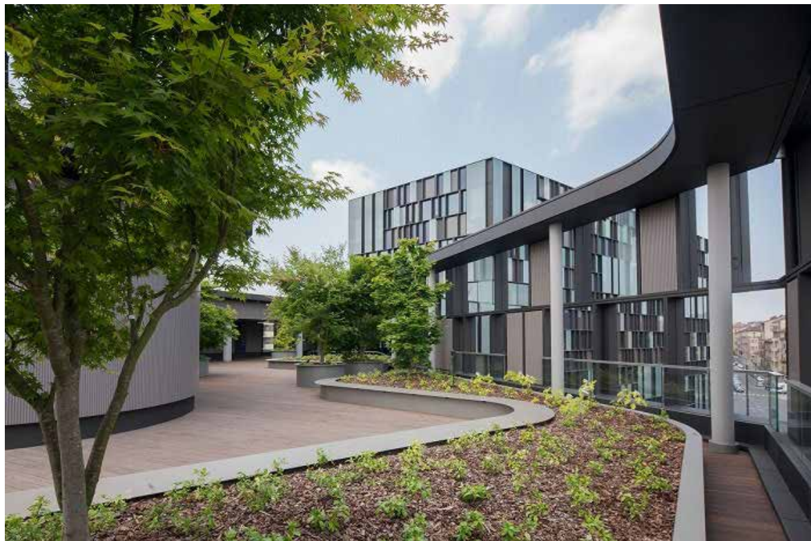
Nuovo centro direzionale Lavazza, vincitore GBC Italia Awards 2017 - LEED
