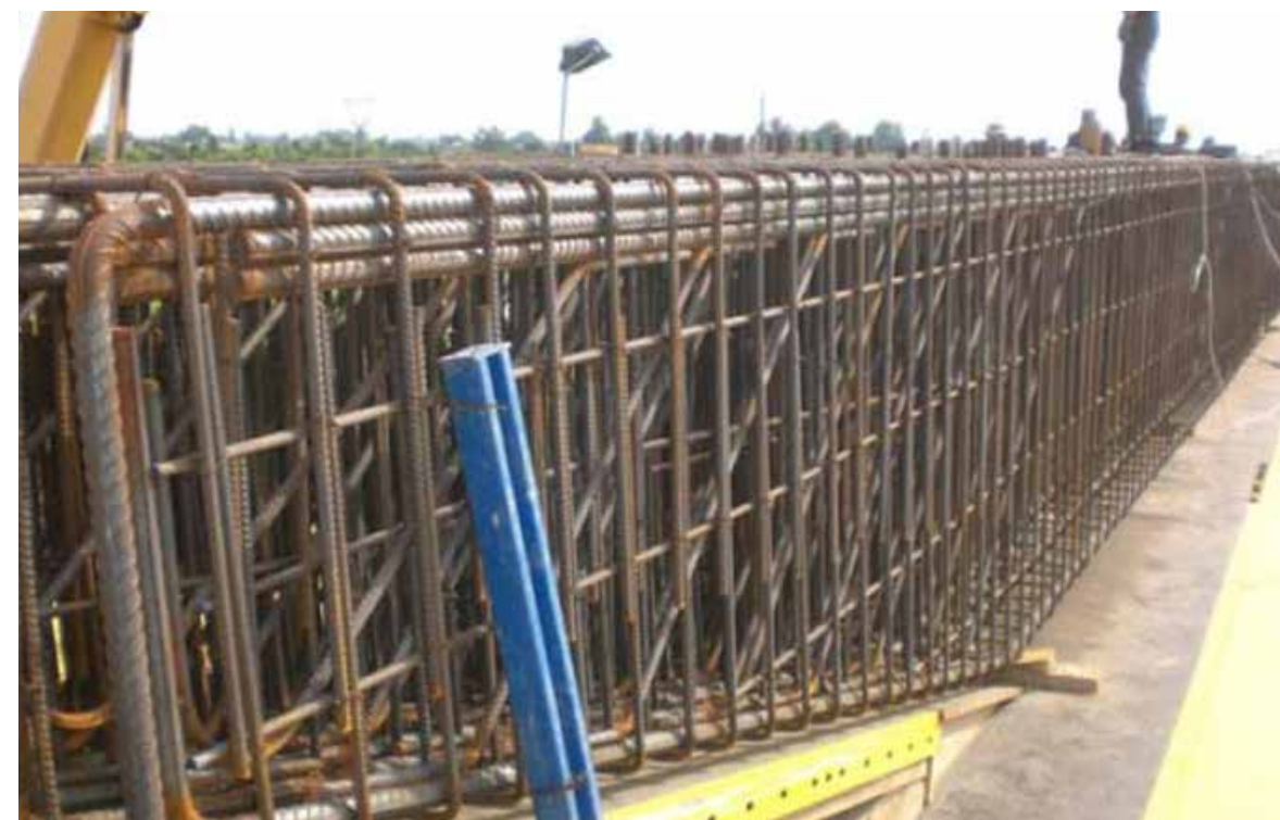
Figure 3. Armatura traverso di una pila.
