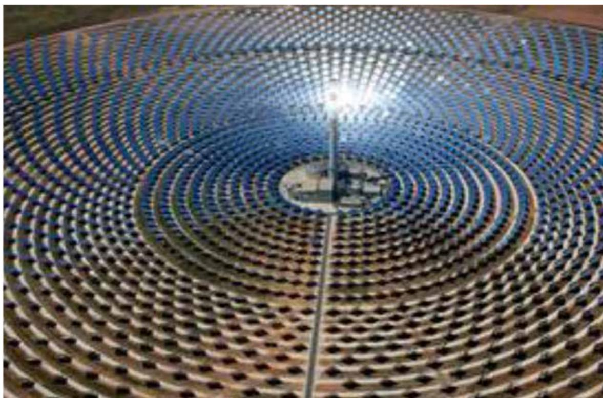
Figura 2. Tecnologia della torre centrale (foto di un impianto Gemasolar)
