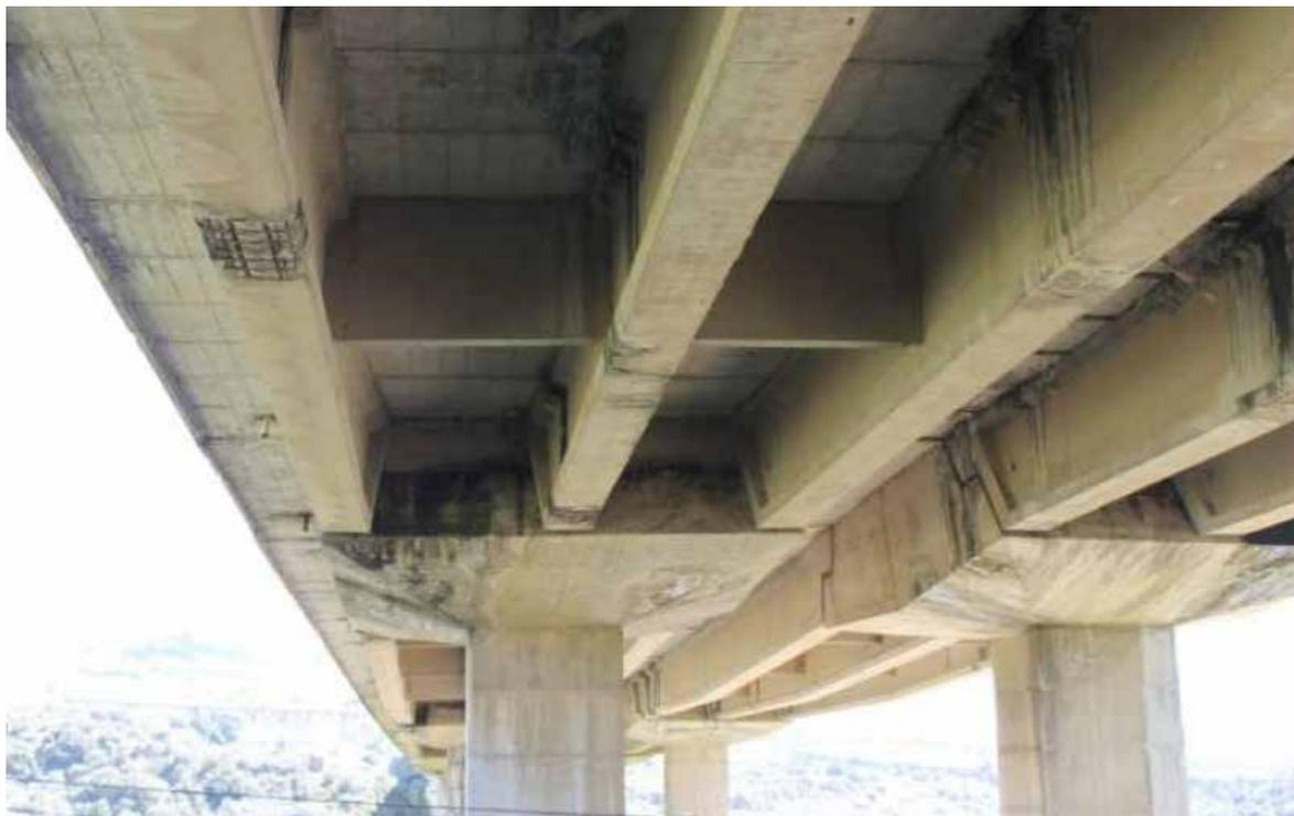
Figura 2. Vista inferiore dell'impalcato costituito da 3 travi in cemento armato precompresso
