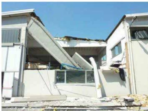
*Fig. 1 – Effetti del sisma 2012 su elementi strutturali di edifici prefabbricati.*
