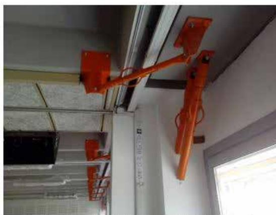
*Fig. 2 – Dispositivi Edilmatic per il miglioramento o l'adeguamento sismico di edifici prefabbricati.*
