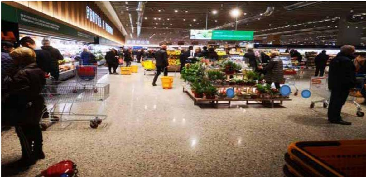
Pavimentazione di punto vendita GDO in calcestruzzo levigato ad alta riflettanza (6.000 mq) - Foto Copyright Stemco S.r.l.
