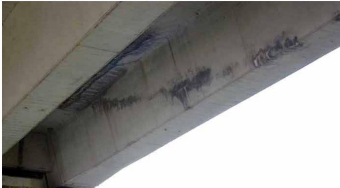
La traccia di "umidità" fa supporre che nella guaina del cavo, forse non correttamente iniettato, sia presente acqua; cosa rimanga dell'acciaio è un mistero
