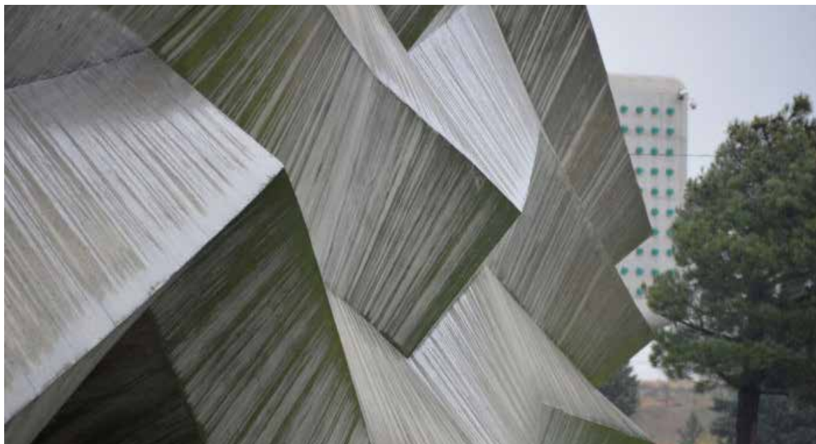
Le pareti in calcestruzzo piegato sono state gettate in opera
