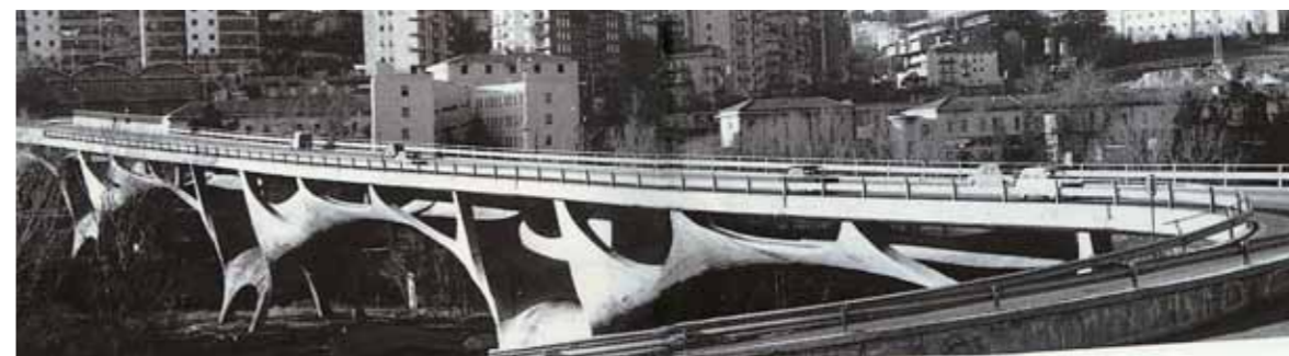
Figura 1. Sergio Musmeci, ponte sul Basento a Potenza
