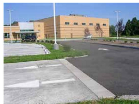
L'indice di riflessione solare (SRI) associa i valori di riflettanza ed emittanza ed esprime la capacità di un materiale di respingere il calore solare e varia da 100 per il bianco standard a 0 per il nero standard: più è elevato, migliore è la prestazione della superficie considerata.
