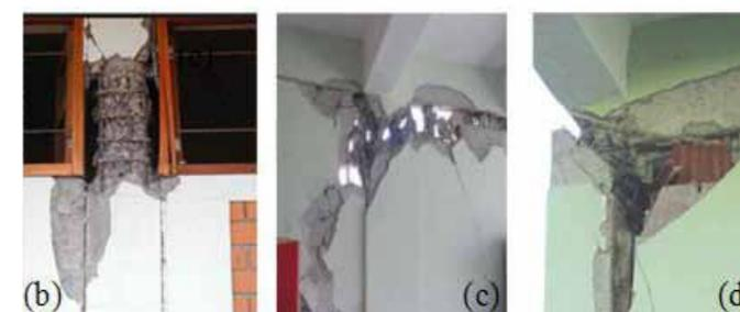
Figura 1. Danni ai telai tamponati derivanti da (a) Piano Debole (2009, L'Aquila), (b) presenza di colonne fragili a taglio (2001, terremoto di Atico, riprodotto da Ayhan Irfanoglu et al 2009, [7]), (c) (d) colonne fragili a taglio interne ed esterne (riprodotto da Haldar et al 2013, [8])
