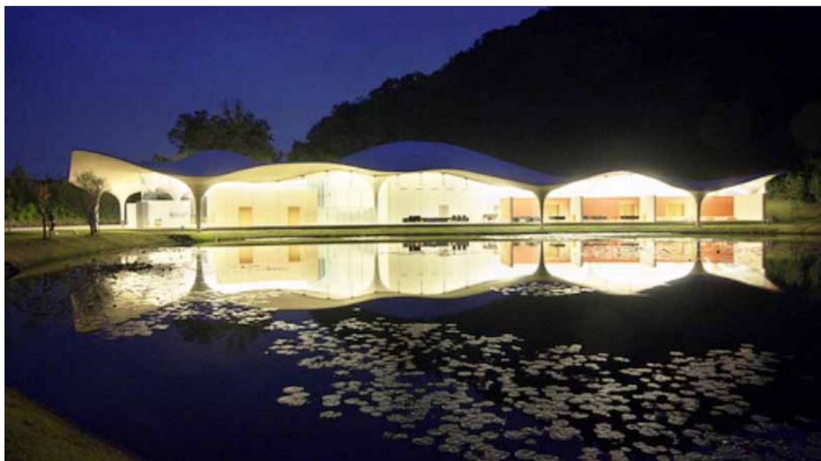
**Figura 1.** Forest of Meditation, Crematorium Center, Gifu, Japan, Toyo Ito & Associates, 2006. Vista durante le ore notturne del Crematorium Center. L'edificio è caratterizzato da una copertura ondulata realizzata in calcestruzzo gettato in opera.
