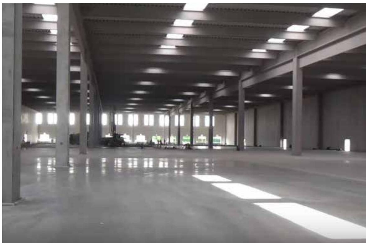
Sono **40.000** i mq di pavimentazione in via di realizzazione presso il cantiere di **Pievesestina** (FC), dove la UNIECO sta realizzando un nuovo centro logistico-industriale. Il Floortek Post Tension Team, grazie alla scelta della committenza di realizzare una pavimentazione innovativa e non tradizionale in calcestruzzo, si sta occupando della progettazione e della messa in opera di 30.000 mq di pavimentazione postesa.
