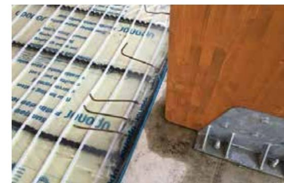
Figura 2. Particolare ferri di collegamento Cordolo-Pavimentazione
