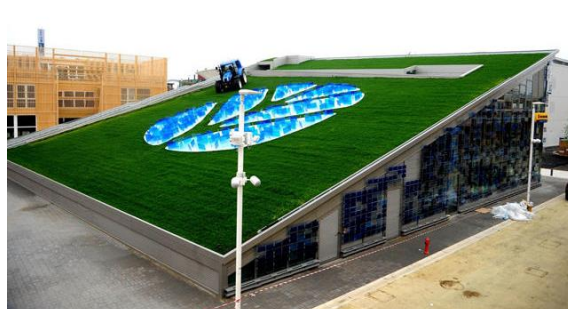
Foto della struttura completata
