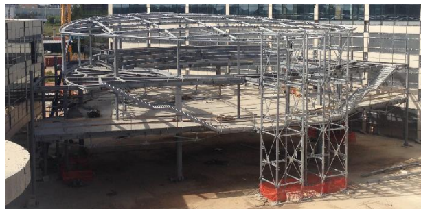
Foto della struttura metallica dell'aula consigliare realizzata
