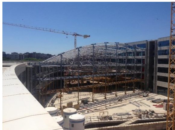
Foto della struttura metallica del Foyer realizzata
