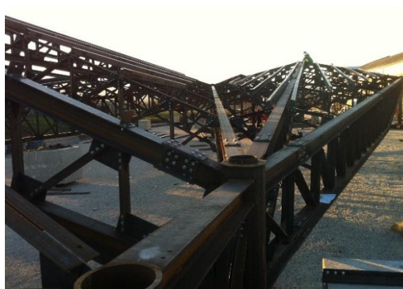
Foto del nodo strutturale realizzato
