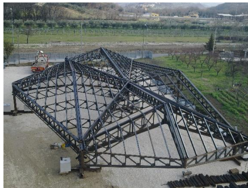
Foto della struttura metallica realizzata
