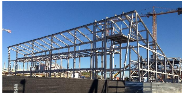
Foto della struttura in acciaio realizzata
