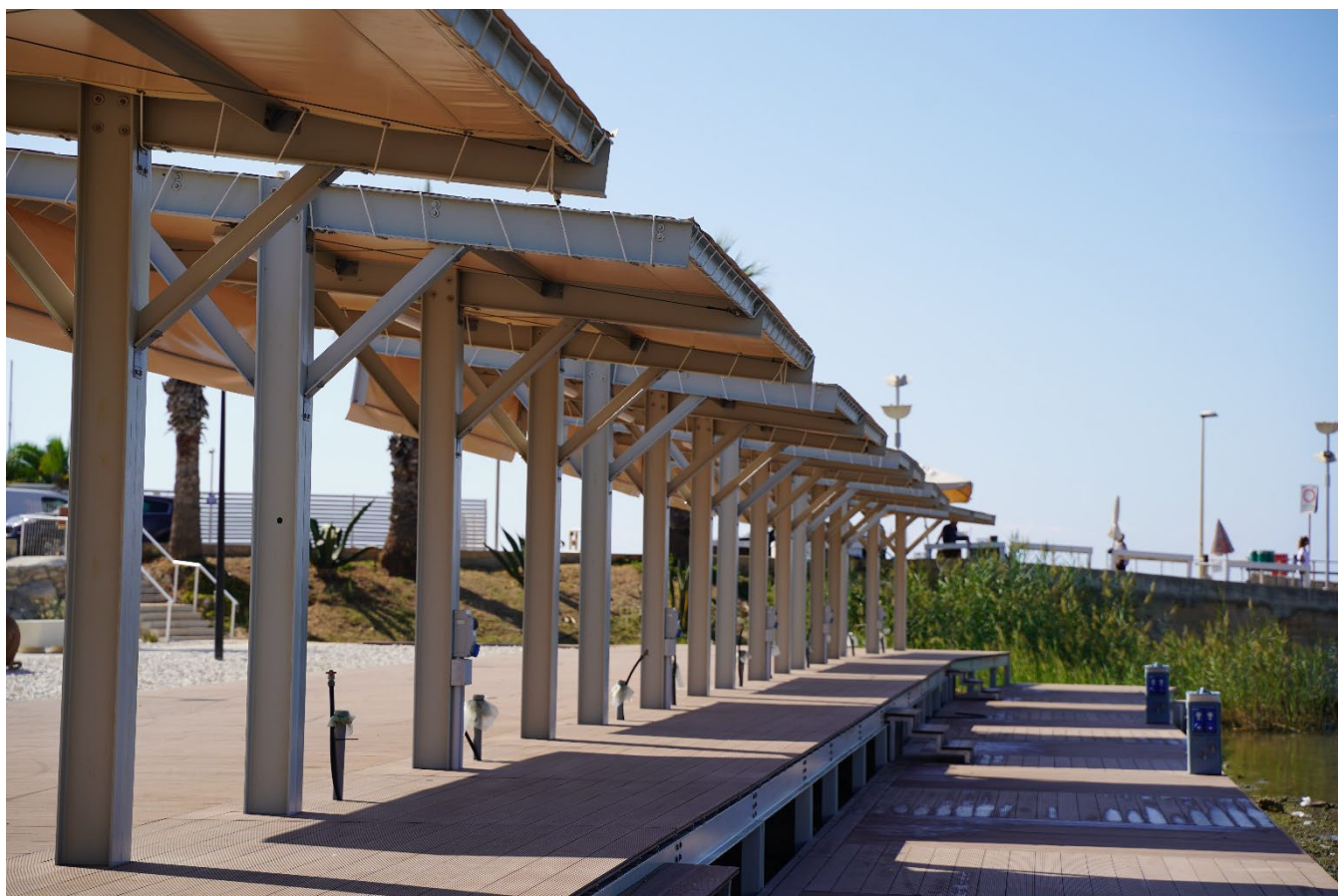
Waterfront sul porto di Scoglitti (RG) ad installazione ultimata, con intelaiatura e pensiline in profili pultrusi in G.F.R.P.
