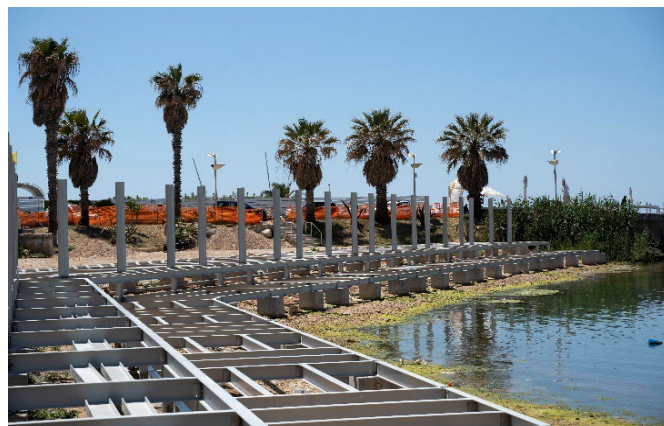
Panoramica dell'intelaiatura in profili pultrusi in G.F.R.P.
