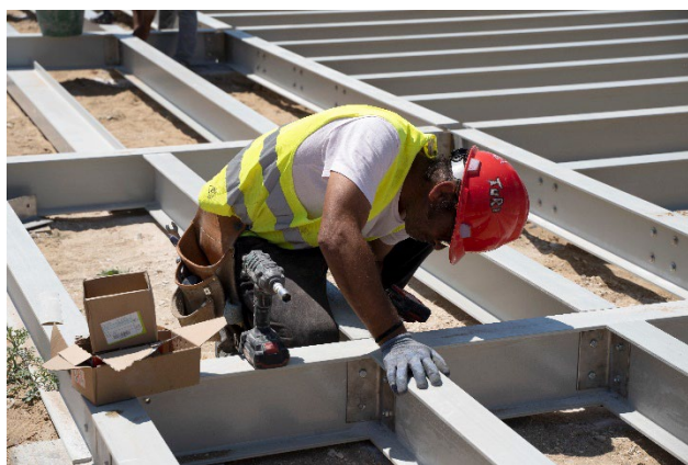
Fase iniziale di installazione
