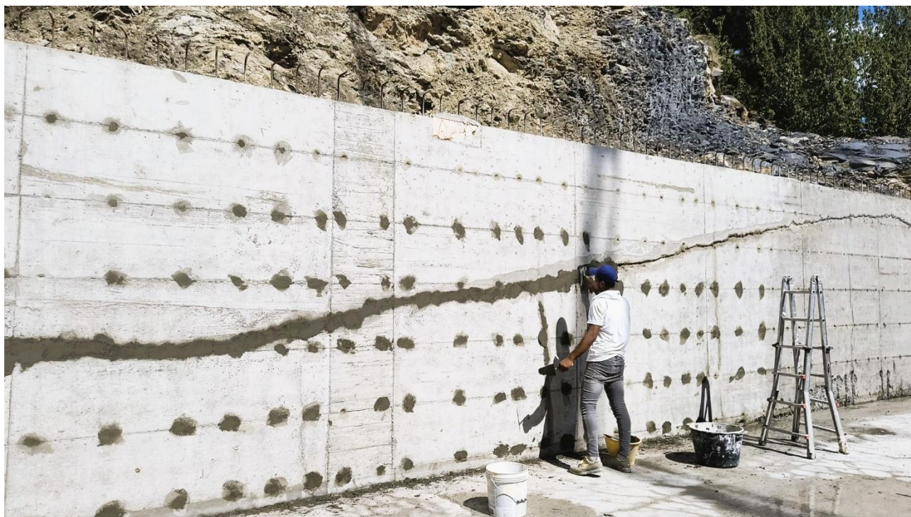
Foto 3: ripristino delle non conformità col ciclo boiacca – malta – boiacca
