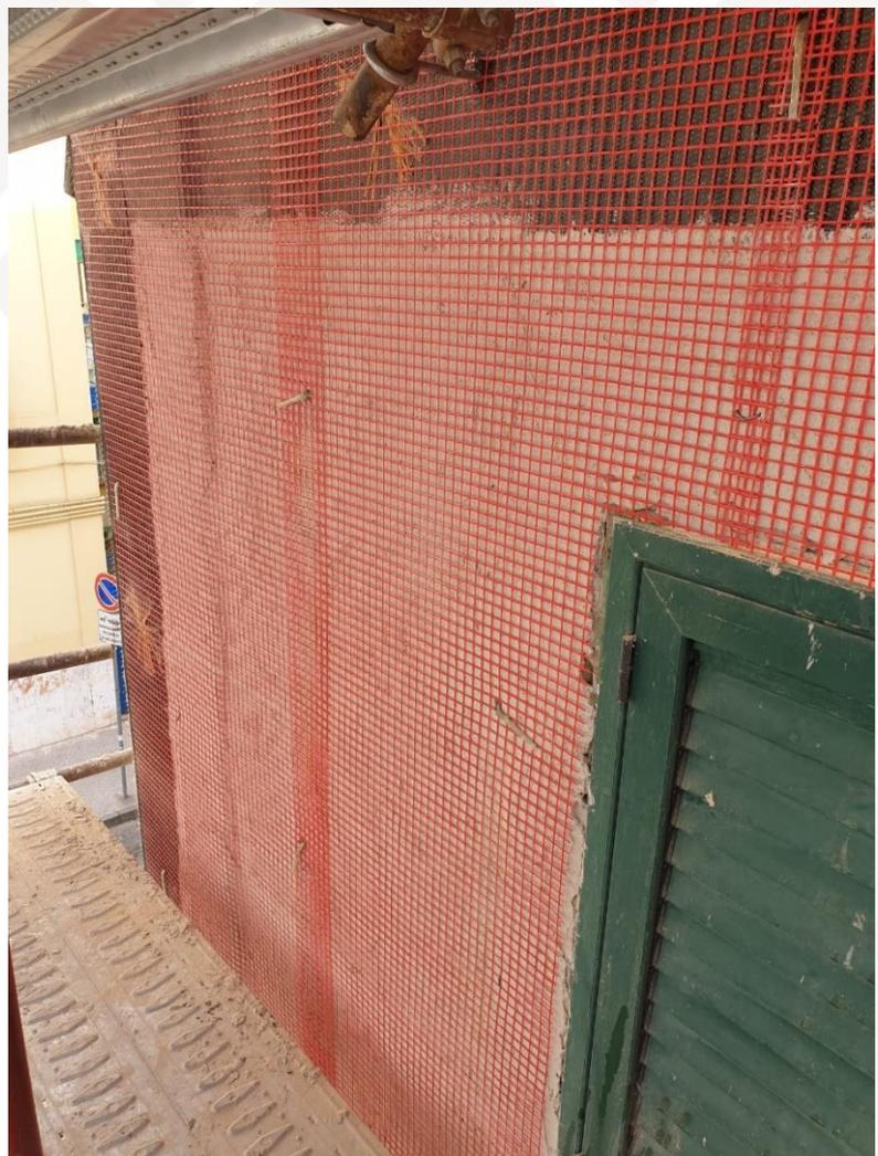
tamponatura che viene collegata al telaio circostante con dei connettori, mediante sistema FRM. Nell'immagine sottostante si riporta il sistema Olympus denominato "OLY-SAFE ANTI-ESPULSIONE: Rinforzo Fuori Piano Tamponature".
