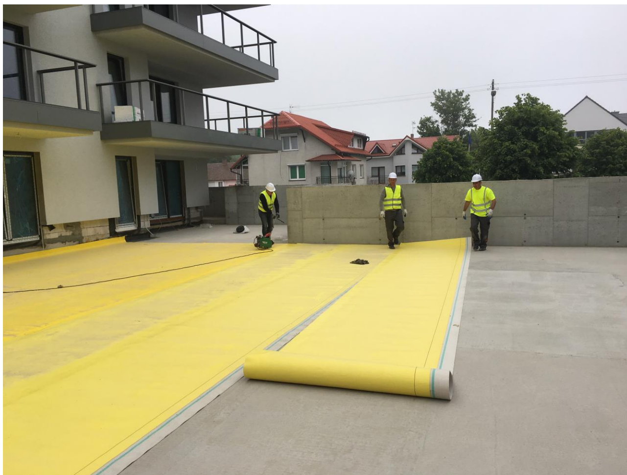
Figura 3 – Membrana impermeabilizzante termoplastica idro-reattiva con nucleo in tecnologia XP.
