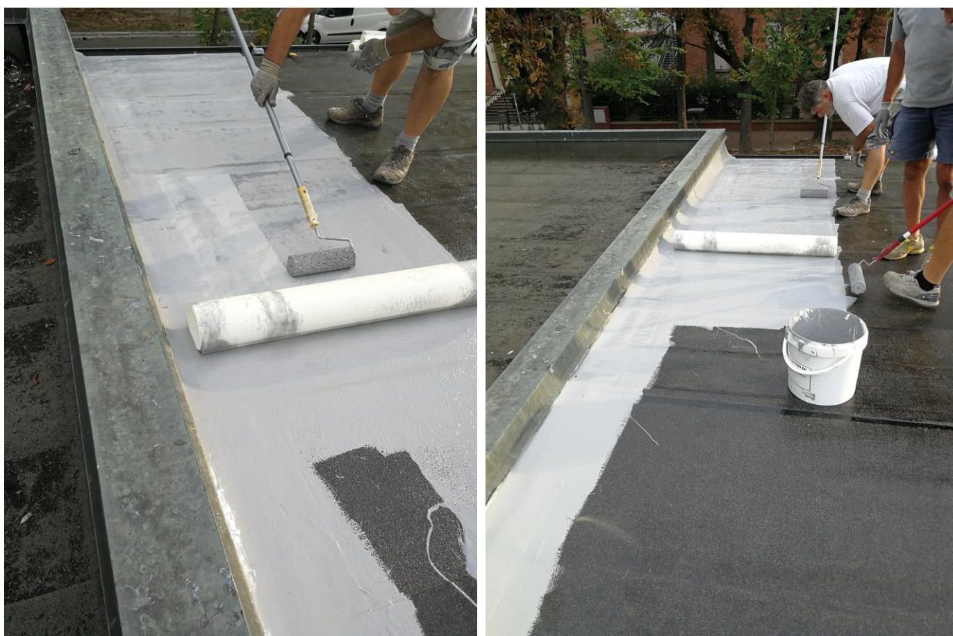
Figura 1 – Esempio di applicazione di ELASTOCOATING EP su copertura piana.
