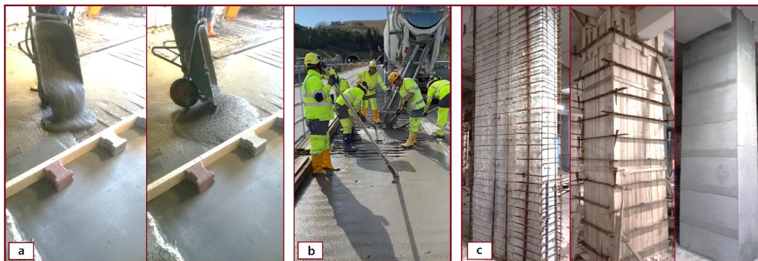
Figura 6 – La posa in opera dei betoncini premiscelati (UNI EN 1504-3) risulta estremamente agevole, sia per getti su superfici orizzontali (a, b) che per getti entro cassero.
