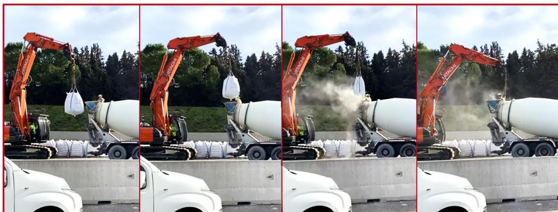
Figura 5 – La soluzione dei betoncini premiscelati (UNI EN 1504-3) può risultare estremamente vantaggiosa anche in particolari cantieri infrastrutturali nei quali l’approvvigionamento di calcestruzzo risulta complesso. L’impiego di big-bags consente di confezionare il materiale all’interno di un’autobetoniera fissa in cantiere.
