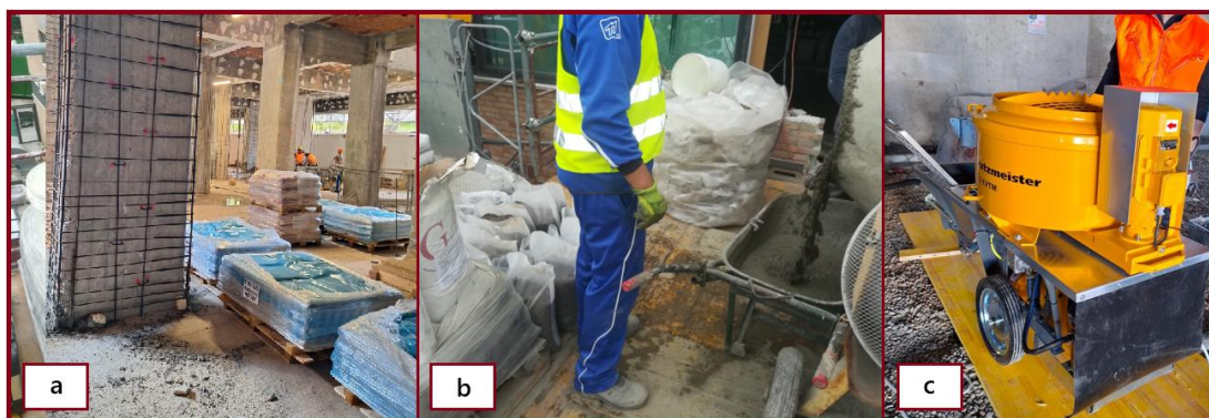
Figura 3 – I betoncini premiscelati (UNI EN 1504-3) semplificano la logistica di cantiere, potendo essere stoccati direttamente in situ e confezionati con betoniera o mescolatore planetario nel momento in cui è prevista la posa in opera.
