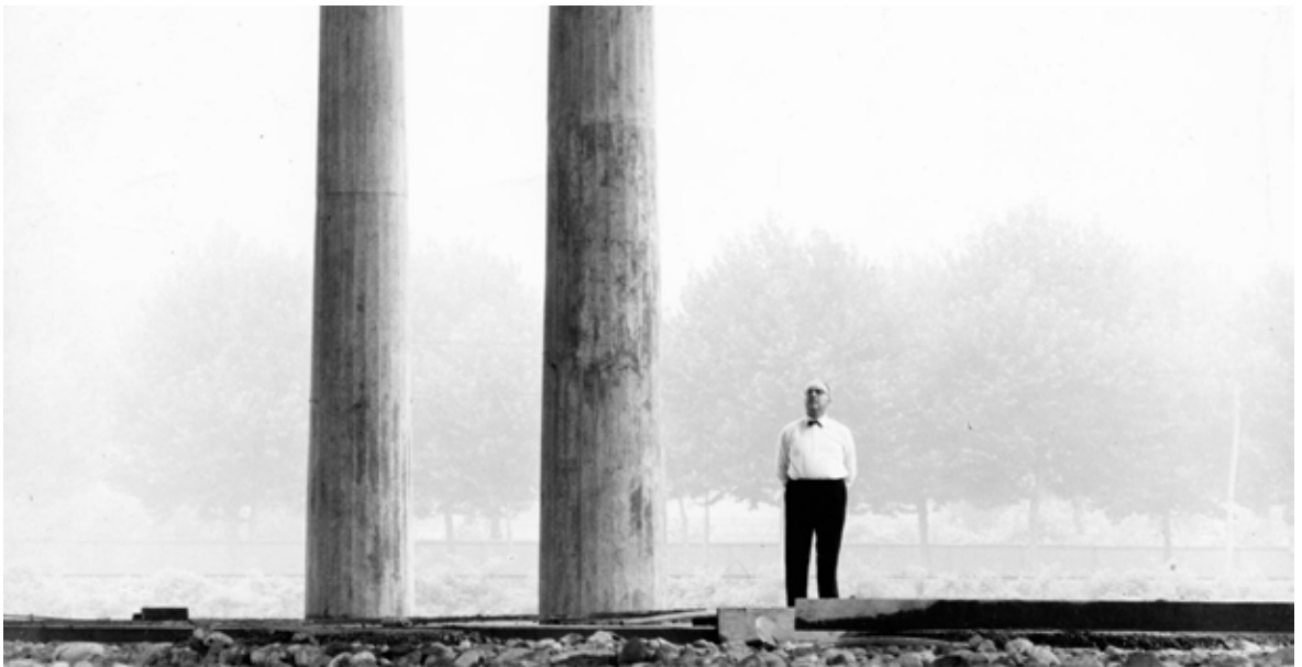
Angelo Mangiarotti, Deposito industriale Splügen Bräu, Mestre (Venezia), 1962, foto Archivio Giulio
