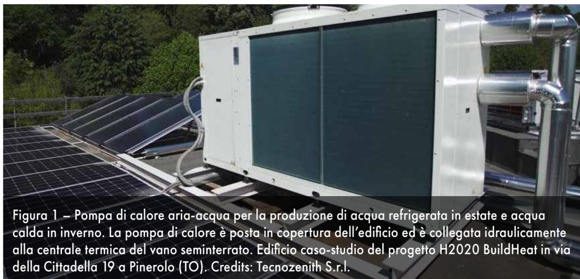
Figura 1 – Pompa di calore aria-acqua per la produzione di acqua refrigerata in estate e acqua calda in inverno. La pompa di calore è posta in copertura dell'edificio ed è collegata idraulicamente alla centrale termica del vano seminterrato. Edificio caso-studio del progetto H2020 BuildHeat in via della Cittadella 19 a Pinerolo (TO). Credits: Tecnozenith S.r.l.
