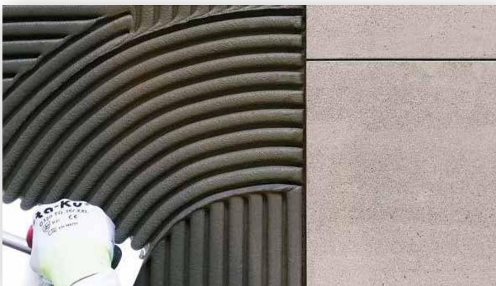
L'articolo fornisce un'analisi dettagliata delle caratteristiche e delle proprietà degli adesivi denominati "autobagnanti", offrendo inoltre alcune indicazioni circa la loro applicazione in ambito edilizio, con particolare attenzione alle pavimentazioni realizzate con piastrelle di ceramica.
