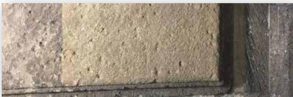
Dettaglio di una bugna in cui si osserva chiaramente la zona sottoposta ad un tassello di pulitura, durante uno studio preliminare.
