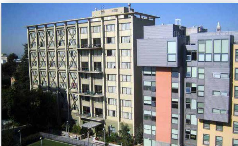
In questo articolo un'analisi degli esoscheletri non solo come strumenti per la mitigazione del rischio sismico ma anche come soluzione architettonica. Un'opportunità per una progettazione integrata volta alla rigenerazione degli edifici.
