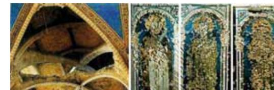
Figura 2 – Crollo delle volte affrescate della basilica superiore di San Francesco ad Assisi e, a destra, risultati del restauro. "Decine i restauratori impegnati nel lavoro di quello che è stato chiamato Il cantiere dell'utopia; 60.000 le ore impiegate, per un costo di 72 miliardi di lire, circa 37 milioni di euro" (da la Repubblica/cultura\_scienze: Riapre la Basilica di Assisi sconfitto il terremoto, 27.11.1999)
