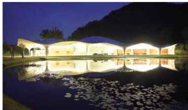
Figura 1 – Forest of Meditation, Crematorium Center, Gifu, Japan, Toyo Ito & Associates, 2006 – Vista durante le ore notturne del Crematorium Center. L'edificio è caratterizzato da una copertura ondulata realizzata in calcestruzzo gettato in opera
