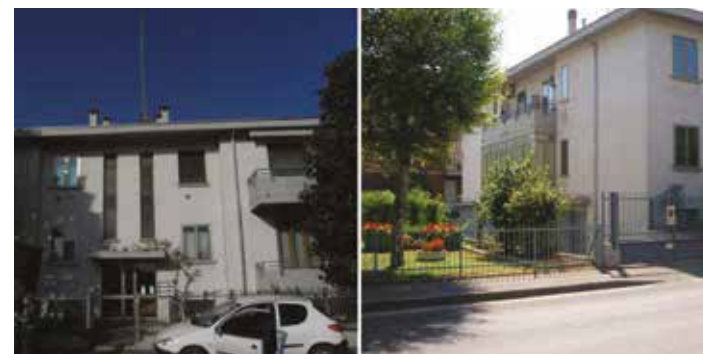
Figura 1 – Edificio oggetto dell'intervento; prospetto sud 8° sinistra) e ovest (a destra)
