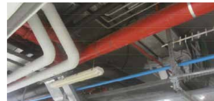
Figura 1 – Ricchezza di contenuti del soffitto piano terreno, dove disporre il passaggio dell'alimentazione elettrica verso il fabbricato uffici
