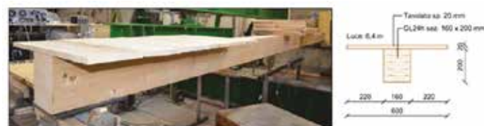
Figura 1 – Solaio oggetto di rinforzo
