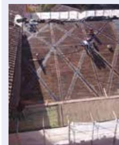
Per la copertura in legno della Basilica di San Domenico a Siena un progetto di consolidamento accurato ha previsto la posa in estradosso di nastri unidirezionali in fibra di carbonio (sistema **BETONTEX-EPOXY di Fibre Net**) posizionati in modo tale da non essere visibili.
