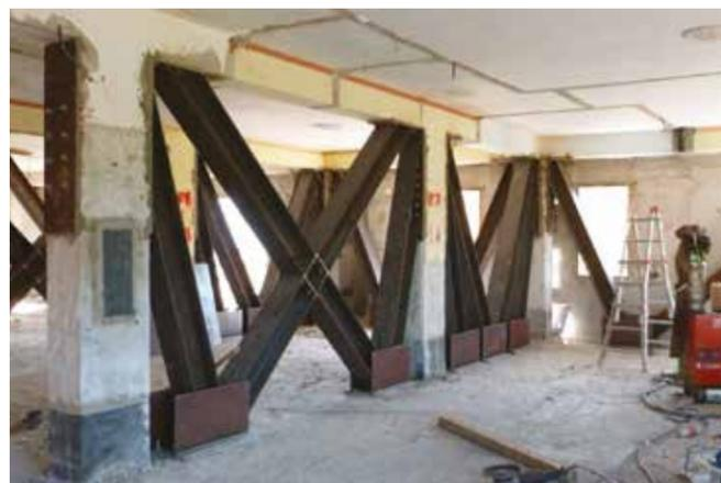
La causa principale di danneggiamento è imputabile all'attivazione di un meccanismo di martellamento tra la struttura ed il muro di contenimento della rampa di accesso, realizzato adiacente all'edificio, determinando effetti torsionali sfavorevoli ed incrementando quindi le sollecitazioni taglianti sui pilastri del piano terra.
