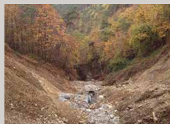
Figura 1 – Dissesti in corrispondenza dei fossi
