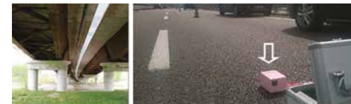
Figura 1 – Sinistra: vista da sotto del viadotto in esame. Destra: disposizione degli strumenti impiegati (indicati dalle frecce), di tipo stand-alone, senza cavi, sulla carreggiata sud. La sincronizzazione tra le diverse unità può avvenire sia via radio che via GPS.
