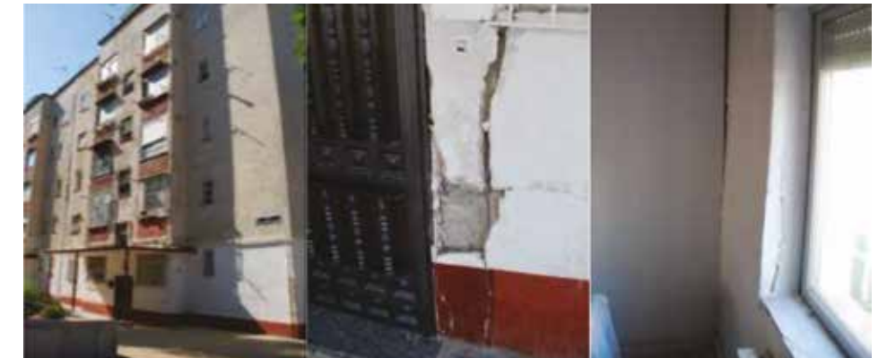
Figura 1 – L'edificio prima della riqualificazione e le crepe rilevate durante i sopralluoghi.
