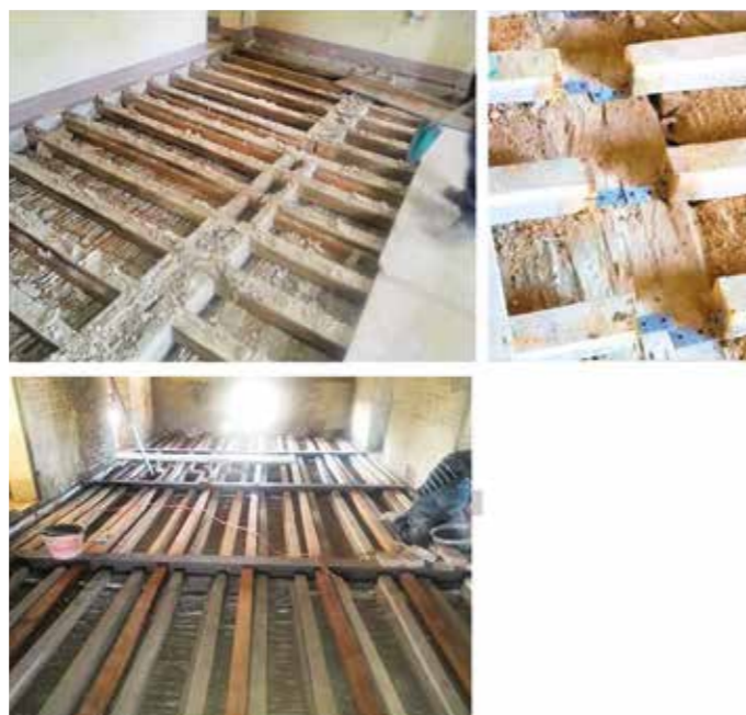
Figura 1 – Fasi di posa della travatura metallica e lignea di rinforzo
