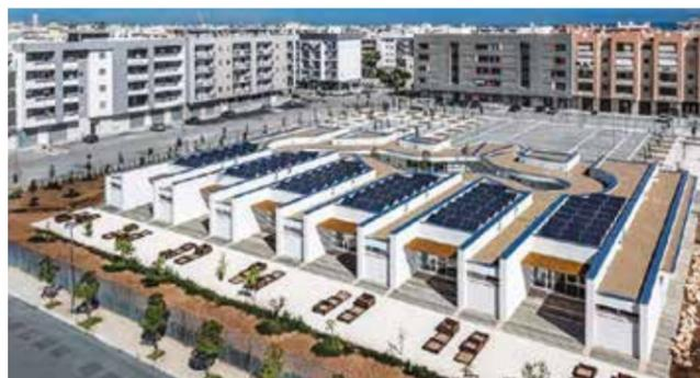
Il sistema costruttivo del fabbricato scolastico, realizzato in setti murari di laterizio armato, è stato scelto per la specificità di materiale biocompatibile, per le caratteristiche di isolamento/inerzia termica e di protezione acustica, e per gli elevati requisiti antisismici e di sicurezza antincendio.
