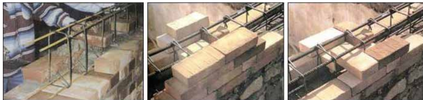
Figura 1 – Cordolo in muratura armata "tradizionale"
