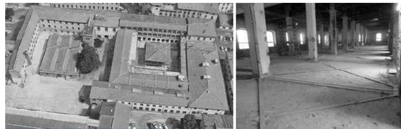
Figura 1 – Ex Manifattura Tabacchi di Lucca, Progetto A.I.C.E consulting S.r.l. Progetto di miglioramento sismico e DL Politecnica Modena. Irrigidimenti di piano con reticolari metalliche
