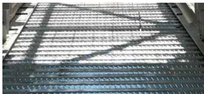
Figura 1 – Lamiera grecata posata nella fase prima del getto della cappa collaborante in c.a.
