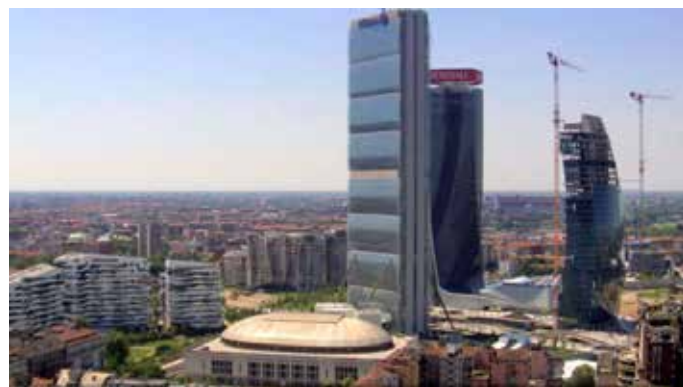
Il cantiere del grattacielo di Libeskind quasi concluso
