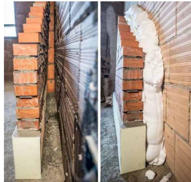
**Figura 1 – Isolamento termico in intercapedine in schiuma poliuretanica.**
