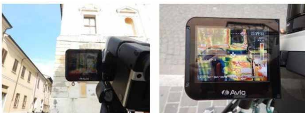
Rilievo di distacchi e discontinuità strutturali (aperture tamponate) su facciata intonacata
