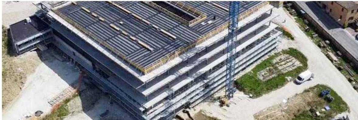
La prova di spinta, seguita dal rilascio improvviso della costruzione, permette di osservare un comportamento dinamico vicino a quello previsto in caso di terremoto e trarne importanti conclusioni sull'adeguatezza dell'opera realizzata e sulla sua coerenza con quanto previsto in progetto. Questo tipo di prova è stato utilizzato per testare la risposta dinamica del nuovo centro ricerca CHIP dell'Università di Camerino.
