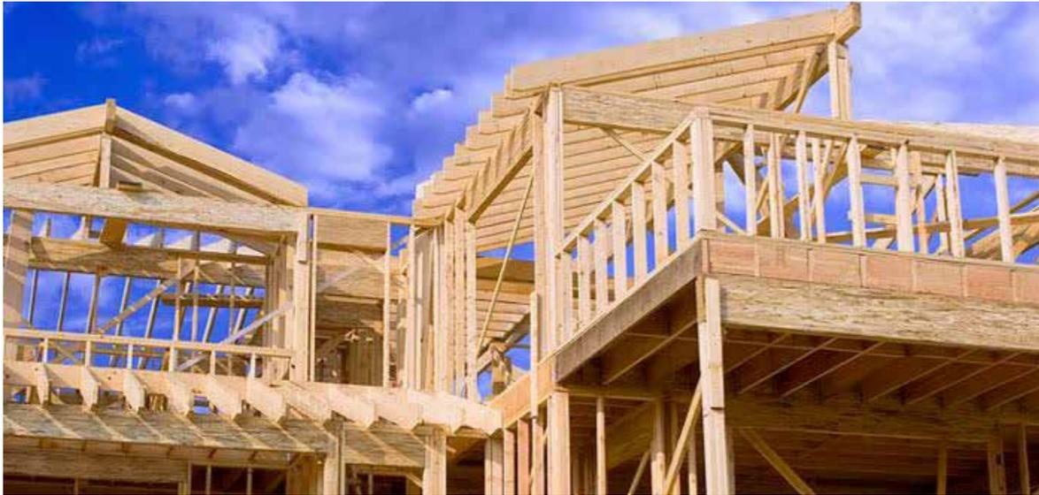
Il presente lavoro intende illustrare un originale modello parametrico agli elementi finiti per supportare lo studio del comportamento di pareti a telaio leggero in legno soggette ad azioni sismiche, ed in particolare la dissipazione energetica legata al danneggiamento delle connessioni chiodate tra i pannelli di irrigidimento ed il telaio principale.
