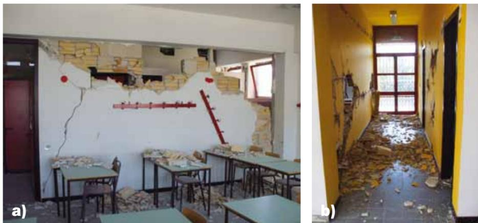
Figura 1 – Esempio di crollo di tramezzature in una scuola in seguito al sisma dell'Aquila, (a) Aula (b) via di fuga
