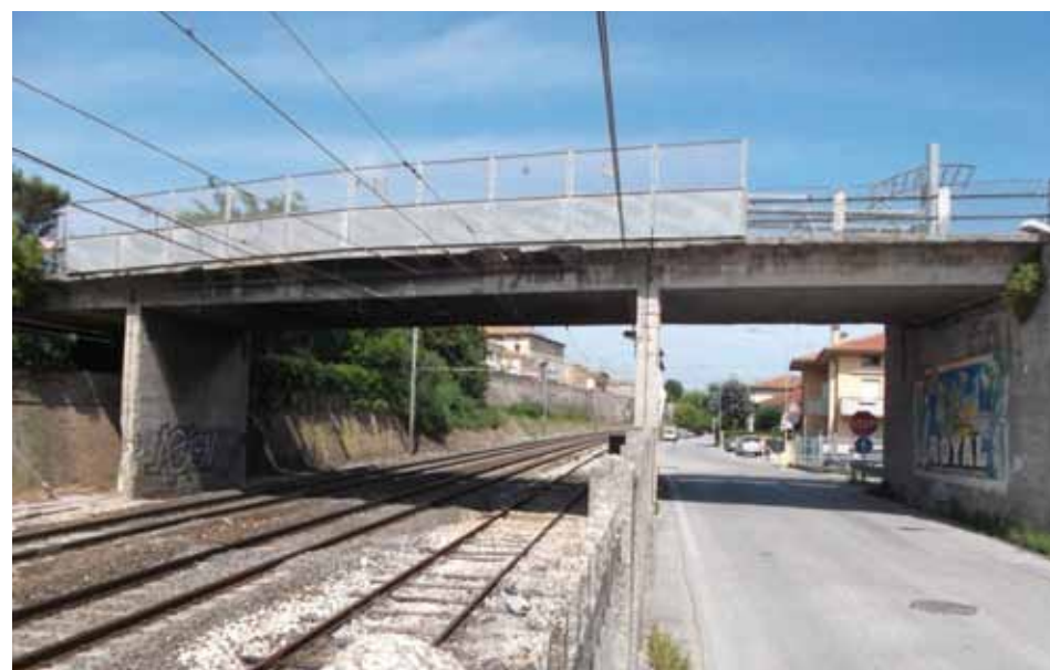
Foto 1 - Vista del ponte a tre campate lato sud
