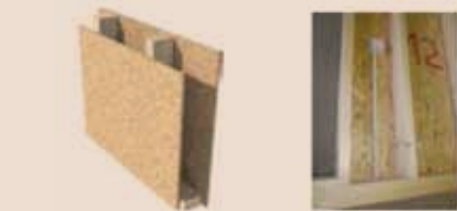
Figura 1 – Telaio in legno e pannellatura controventante.
