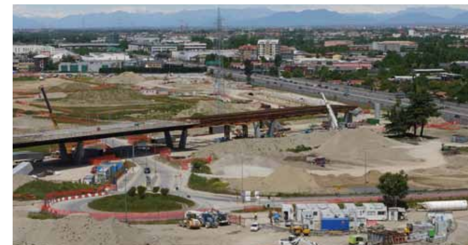
Panoramica cantiere (fonte expocantiere.expo2015.org)
