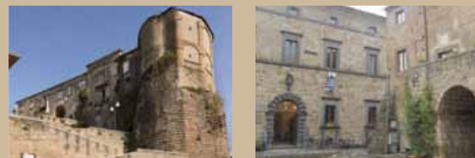
Esempi di edifici realizzati in muratura di tufo
