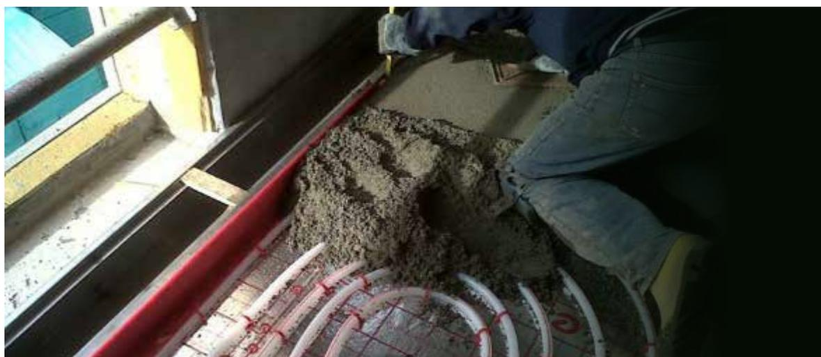
I sistemi radianti a pavimento possono essere suddivisi in due categorie: sistemi ad alto spessore definiti anche tradizionali, oppure sistemi a basso spessore. La caratterizzazione di queste due tipologie non è definita in nessuna normativa: nel presente articolo sono descritte entrambe le tipologie in termini di spessori, materiali e applicazioni, con particolare focus sul tema dei massetti realizzati in opera.
