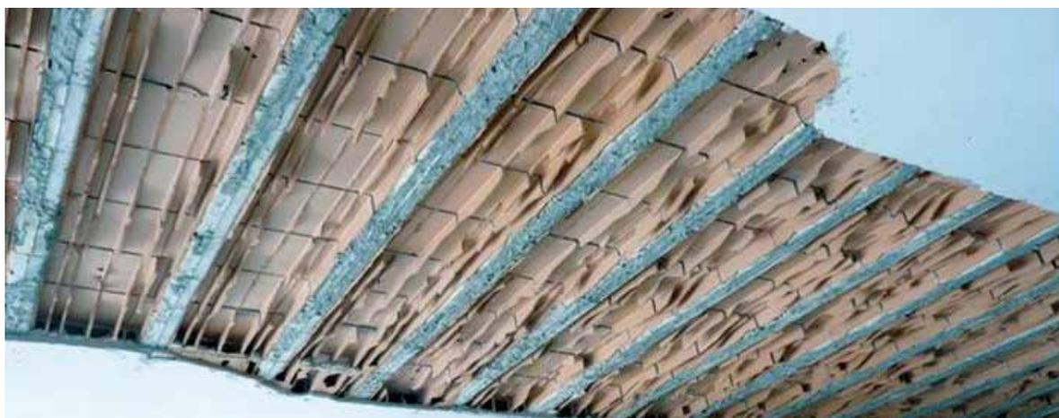
In presenza di anomalie costruttive, difetti progettuali e/o di carenze di manutenzione, nell'ambito dei solai in laterocemento si possono verificare dissesti che, sebbene non comportino pregiudizio per la capacità portante complessiva, risultano essere potenzialmente assai pericolosi per l'incolumità delle persone: si tratta del distacco (spesso repentino) delle cartelle inferiori dei blocchi in laterizio ovvero del cosiddetto sfondellamento del solaio.
